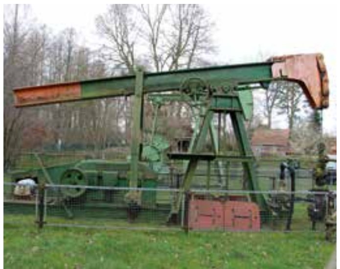
Die große Pumpe wurde einst zur Erdölförderung genutzt.
